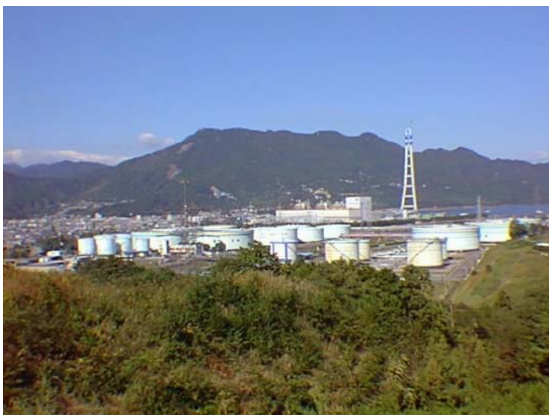
石油工場と火力発電所
