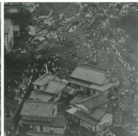
古江町被害写真
