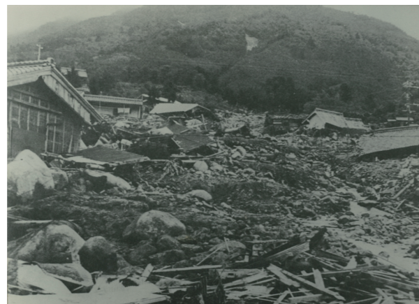
賀田町被害写真
