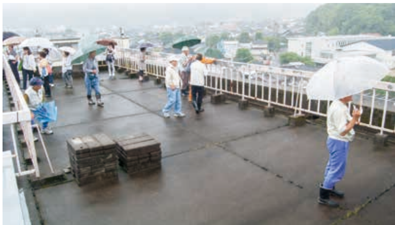
屋上避難スペース 緊急時の一時的避難が可能 避難場所である中村山公園が見える 屋上の海拔 25m
