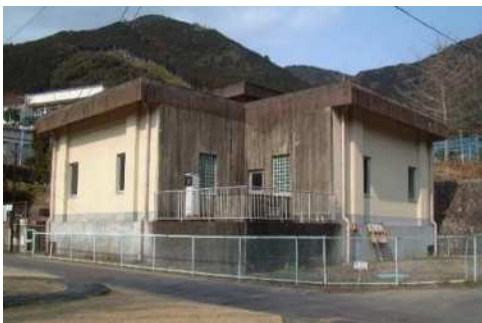
賀田第2加圧ポンプ場
