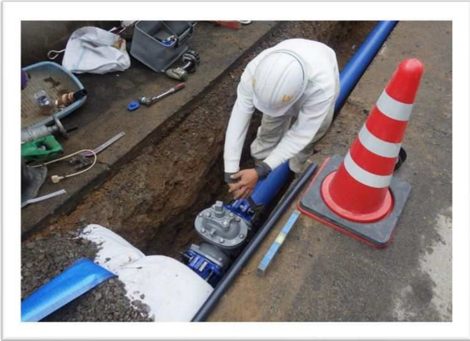
配水管布設替工事
