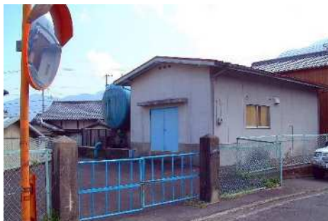
泉加圧ポンプ場
