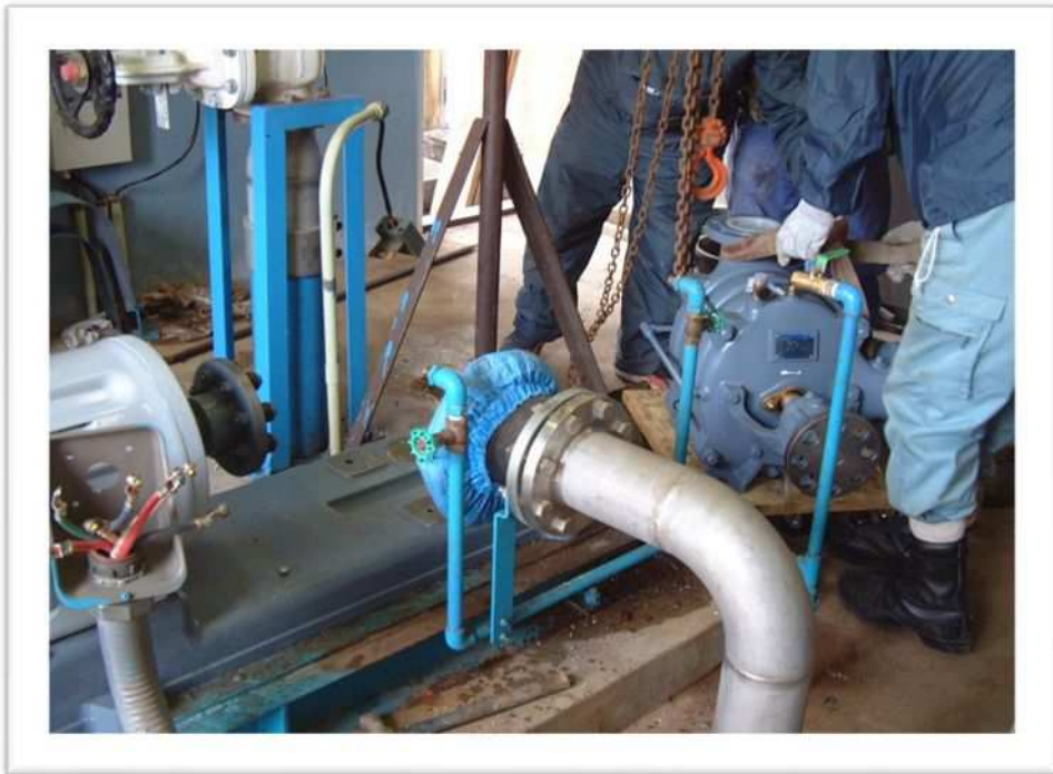
ポンプ取替工事
