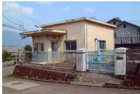
光ヶ丘送水ポンプ場
