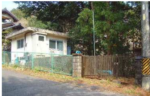
馬越送水ポンプ場
