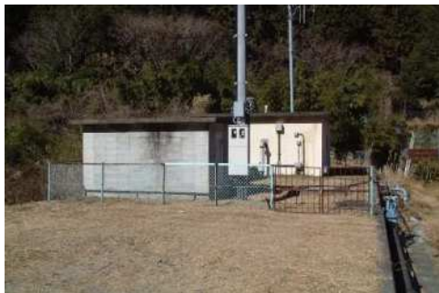
賀田第1(北)浄水場
