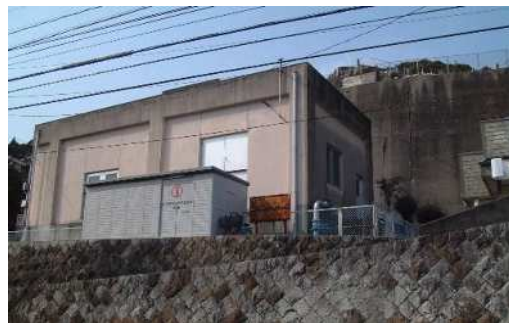
古江加圧ポンプ場
