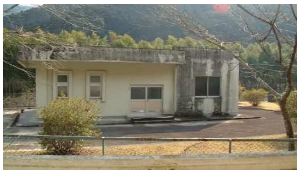
三木里浄水場
