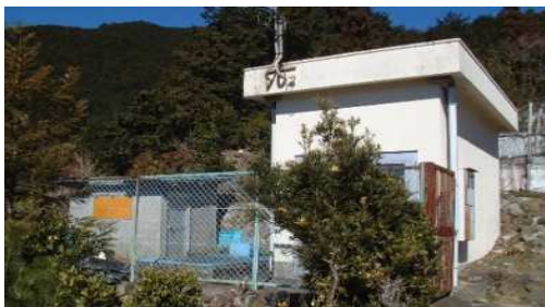
三木浦第1浄水場
