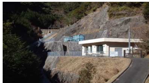
三木浦第2浄水場
