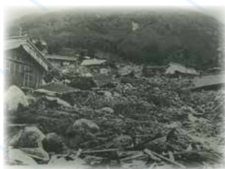
古江町の被害写真
