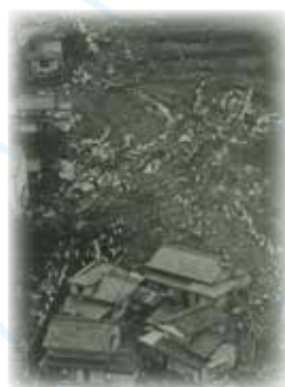
賀田町の被害写真
