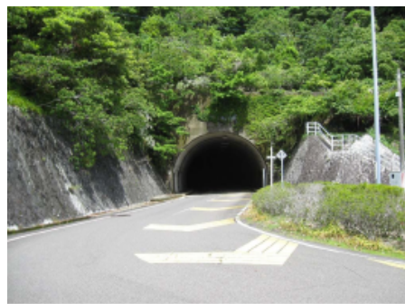
▲ 起点側(梶賀側)
