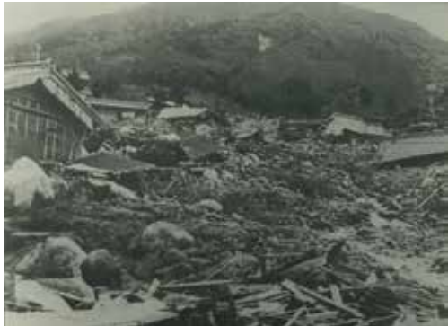
賀田町の被害写真
