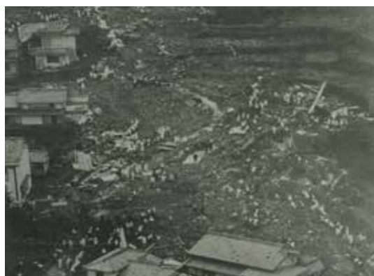
古江町の被害の様子
