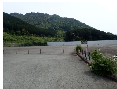
防災施設（ヘリポート）
