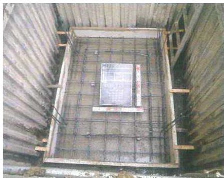
基礎底板の状況
