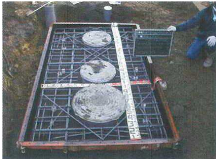
スラブ工事の状況
