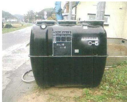
浄化槽本体及び浄化槽搬入状況 （浄化槽の型式がわかるように）
