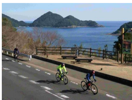
国道 311 号太郎坂広場[熊野市]
