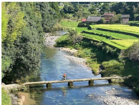
尾川川沈下橋[熊野市]
