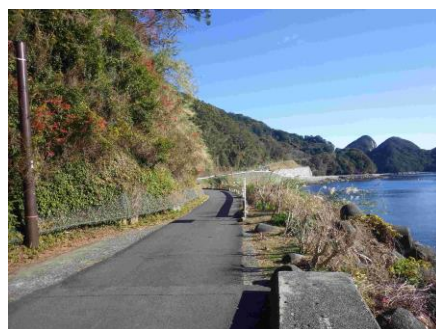
国道 311 号 狭隘箇所[熊野市]
