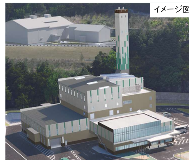
東紀州広域ごみ処理施設
